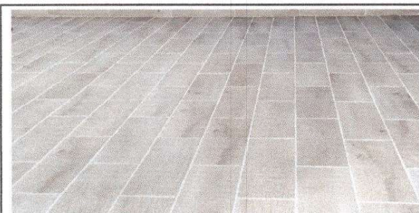
Foto 5: finalizacion de piso de torta de concreto por ceramico.
