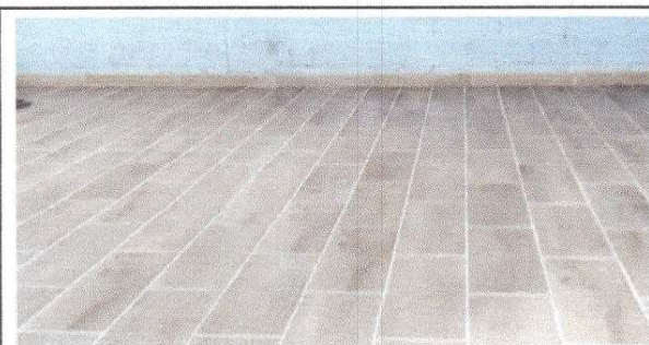
Foto 3: finalizacion de piso de torta de concreto por ceramico.
