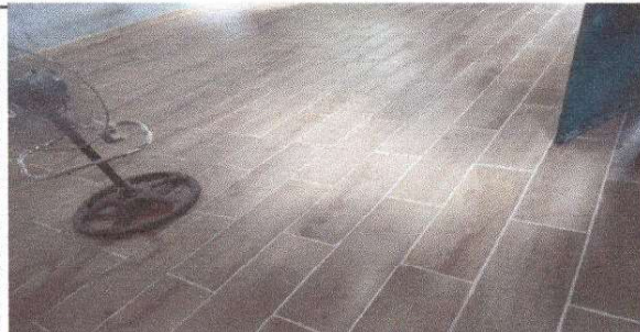
Foto 4: finalizacion de piso de torta de concreto por ceramico.
