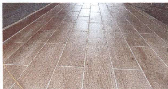
Foto 2: finalizacion de piso de torta de concreto por ceramico.
