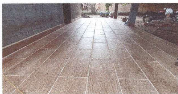
Foto1: finalizacion de piso de torta de concreto por ceramico.
